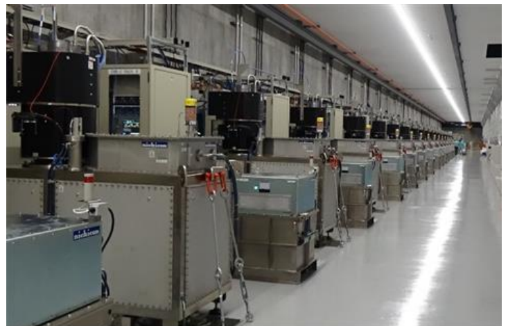
クライストロン電源用の超高精度高電圧充電器（ラック内）、モジュレータ 各21台
